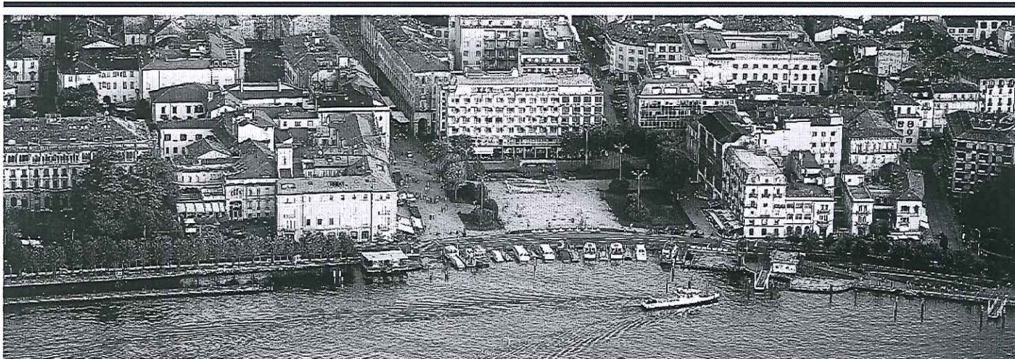
La fascia a lago in cui si vede lo stato del cantiere delle paratie, arrivato a un terzo
