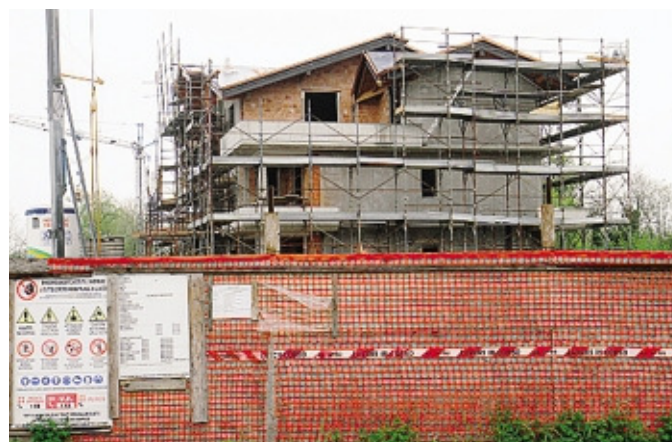
Un cantiere sotto sequestro ARCHIVIO
