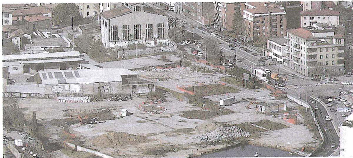
Dall'alto Qui, all'ingresso di Como, sorgeva la fabbrica Ticosa demolita nel 2006. Al suo posto sarebbe dovuto sorgere un quartiere modello (Cusa)
