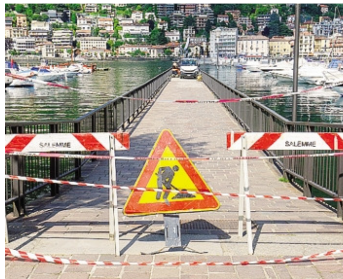
La diga foranea chiusa al passaggio dei pedoni BUTTI
