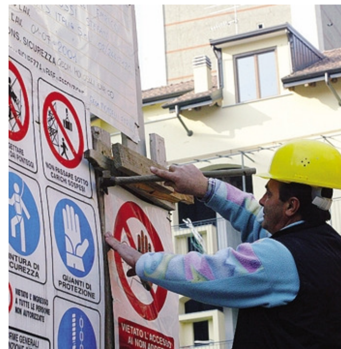
Accordo tra Ance e Comune per i lavori di manutenzione
