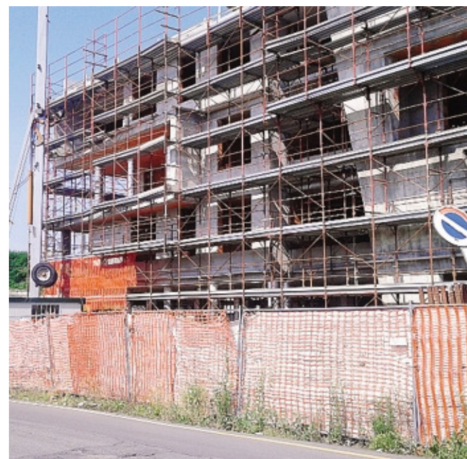
Il cantiere avviato tra via Borromeo, via San Carlo e via Sauro
