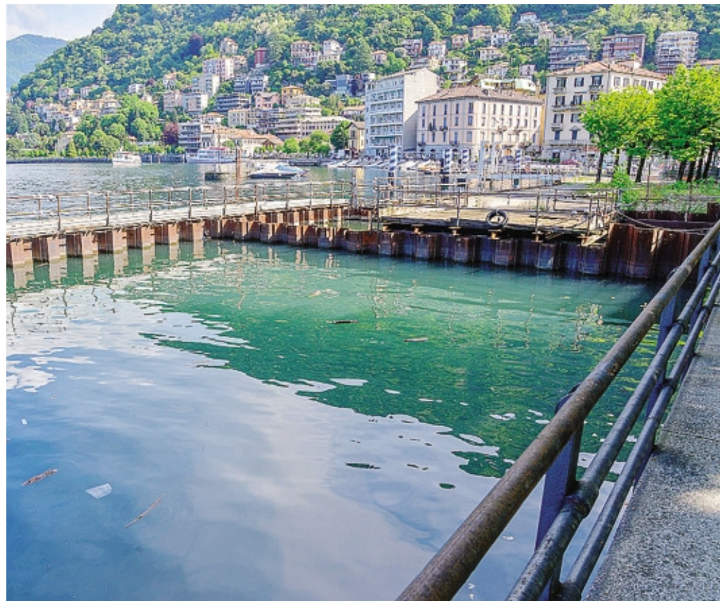
Il cantiere inizierà dalla zona di Sant'Agostino e procederà per piccoli tratti
