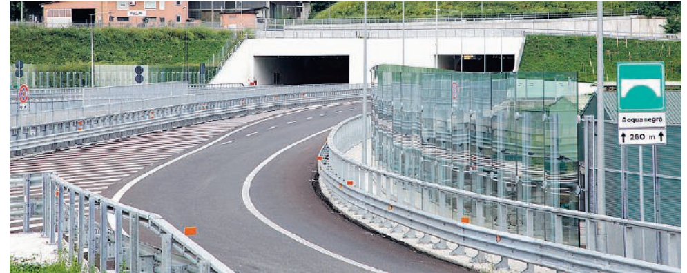
Il primo tratto della tangenziale di Como è già operativo; la speranza è vedere completata l'opera con il secondo lotto
