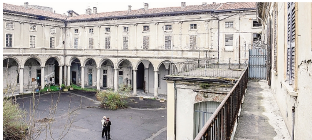
L'ex orfanotrofio di via Grossi: regna il degrado
