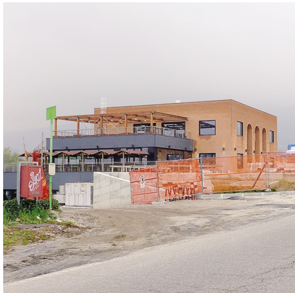
L'intervento in corso sull'area dell'ex Hotel Erba è uno dei pochi nel settore dell'edilizia BARTESAGHI
