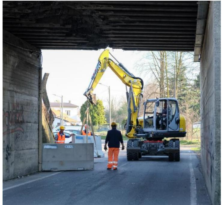
La posa delle barriere di new jersey per sbarrare l'accesso alla strada sotto il ponte danneggiato
