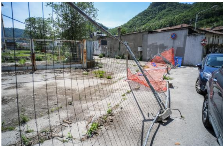
Il grigliato da cantiere pericolosamente divelto dall'ultima ondata di vento in città (Nassa)
