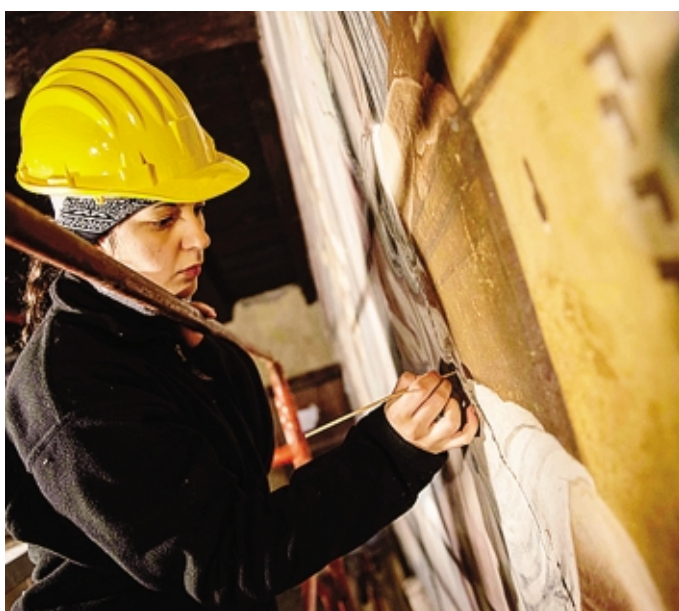
Una studente della Galli al lavoro in cantiere
