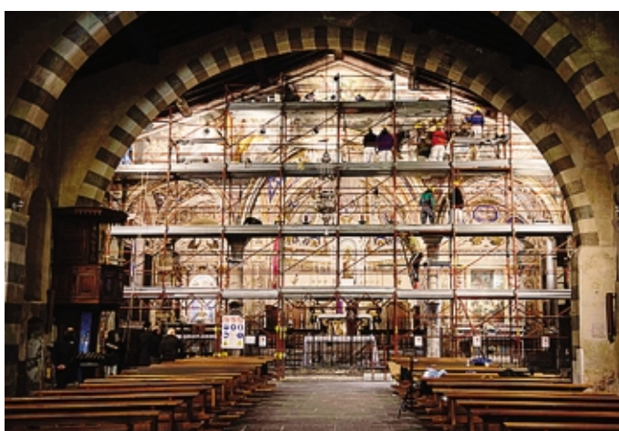
Il cantiere alla chiesa di san Giovanni Battista a Torno
