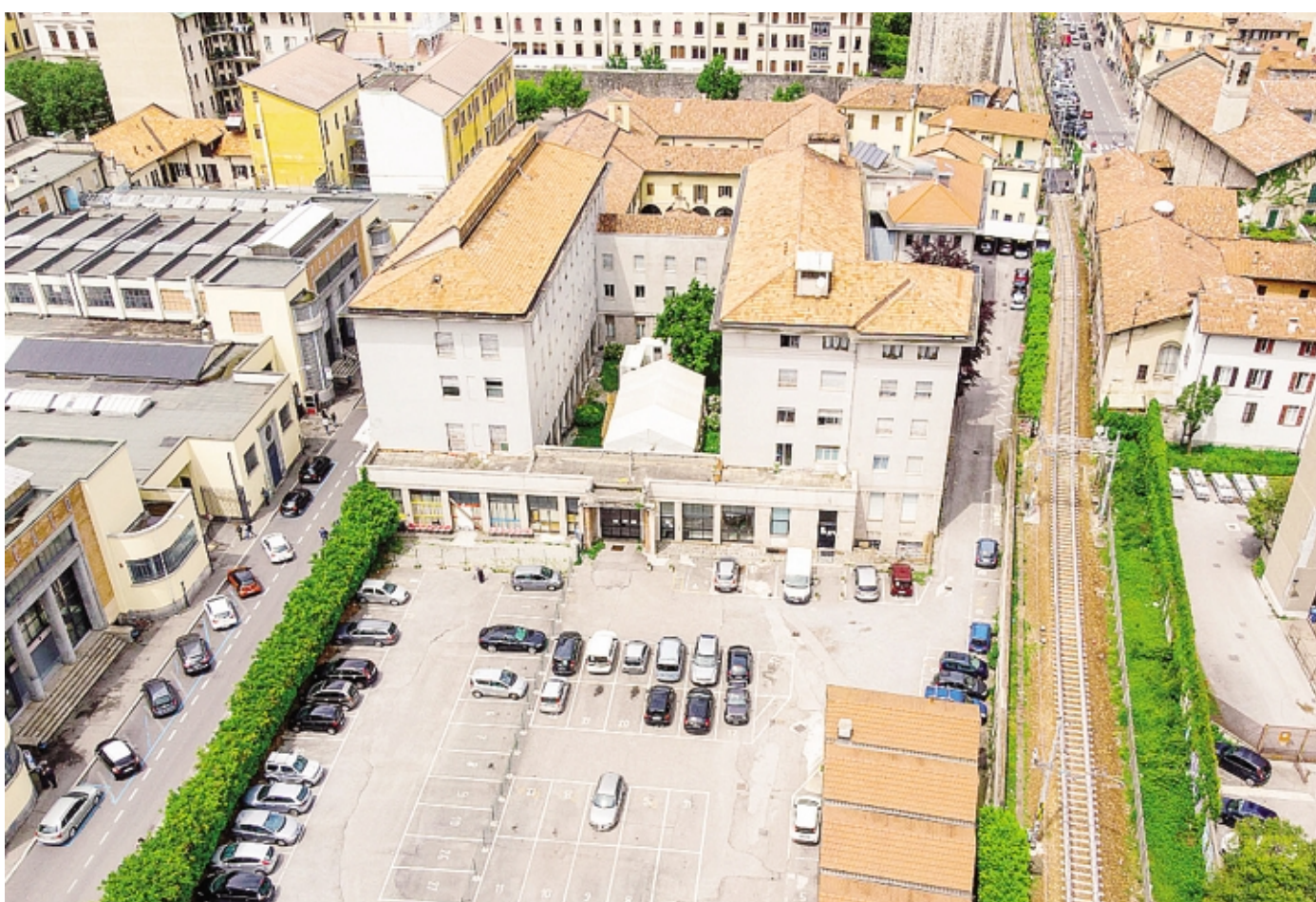
Il complesso del Cardinal Ferrari, tra viale Battisti e via Sirtori: la parte più nuova (le due "ali" laterali) verrà abbattuta
