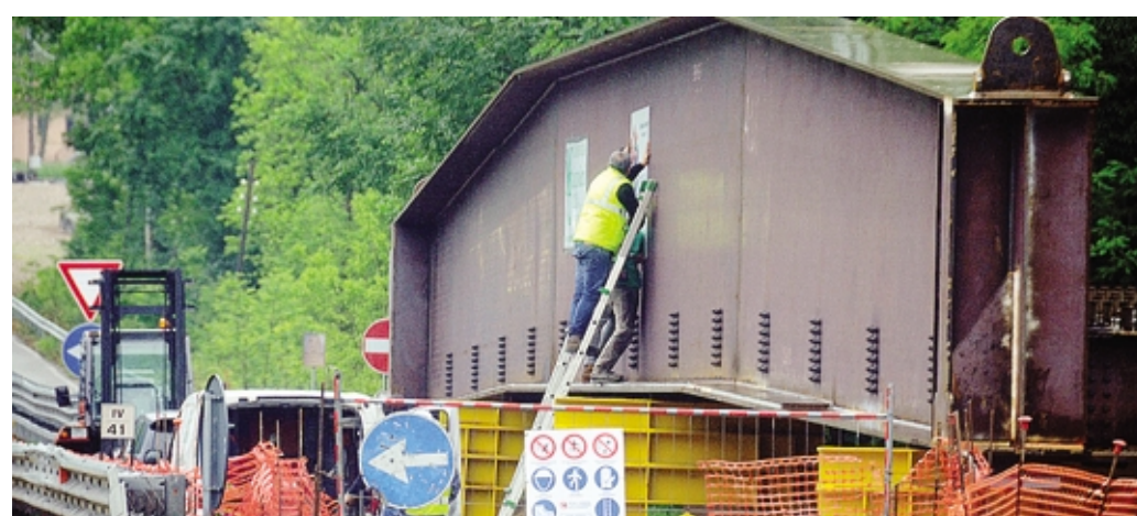
Un pezzo della campata del nuovo ponte che verrà posata all'altezza di Annone
