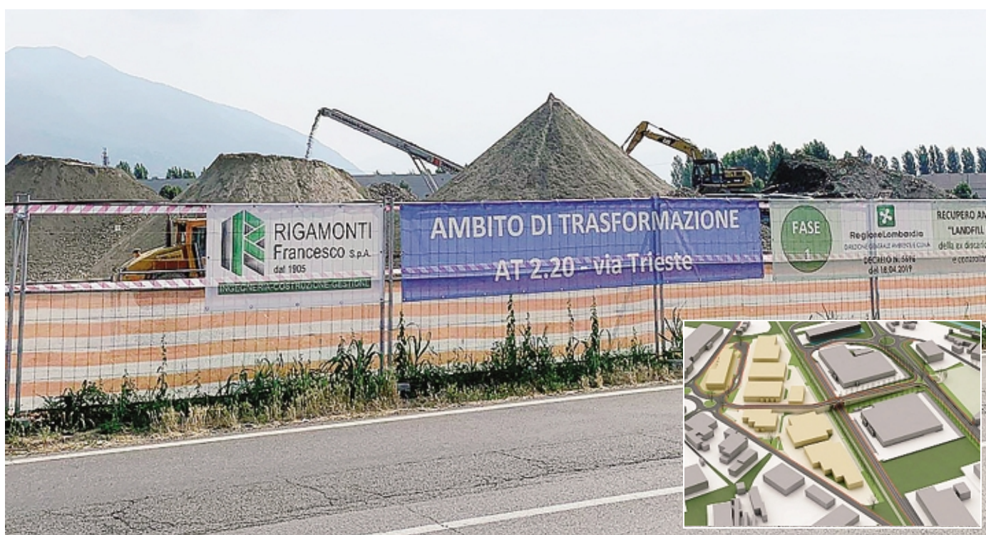
Il cantiere di via Trieste che è stato aperto nei giorni scorsi e, nel riquadro, il rendering del progetto industriale FOTO BARTESAGHI
