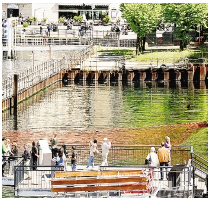
L'area delimitata del cantiere della paratie
