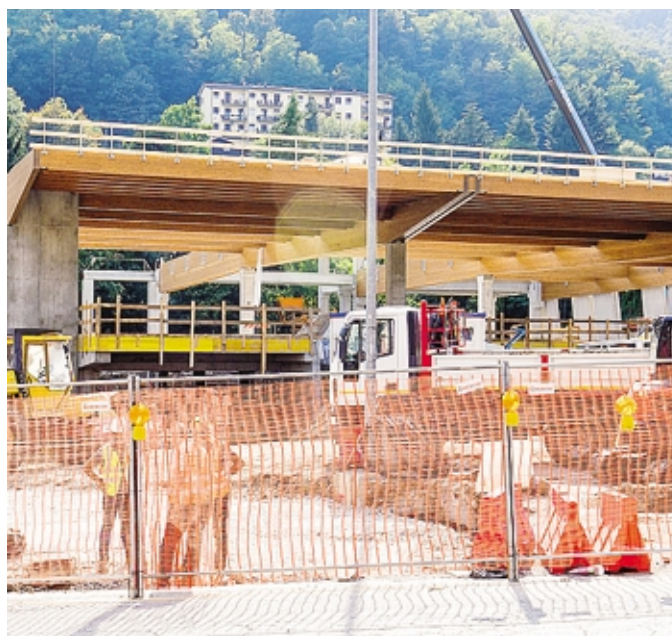
Il cantiere del supermercato aperto recentemente a Monte Olimpino
