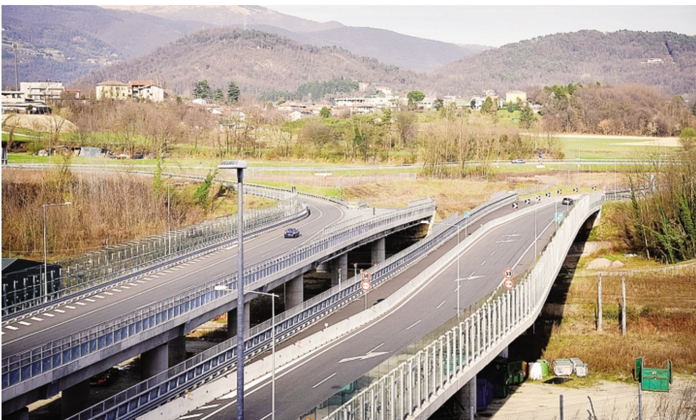
Il primo lotto della tangenziale di Como finisce in via Acquanera, ma di fatto si ferma nel nulla. Da lì dovrebbe partire il secondo tratto
