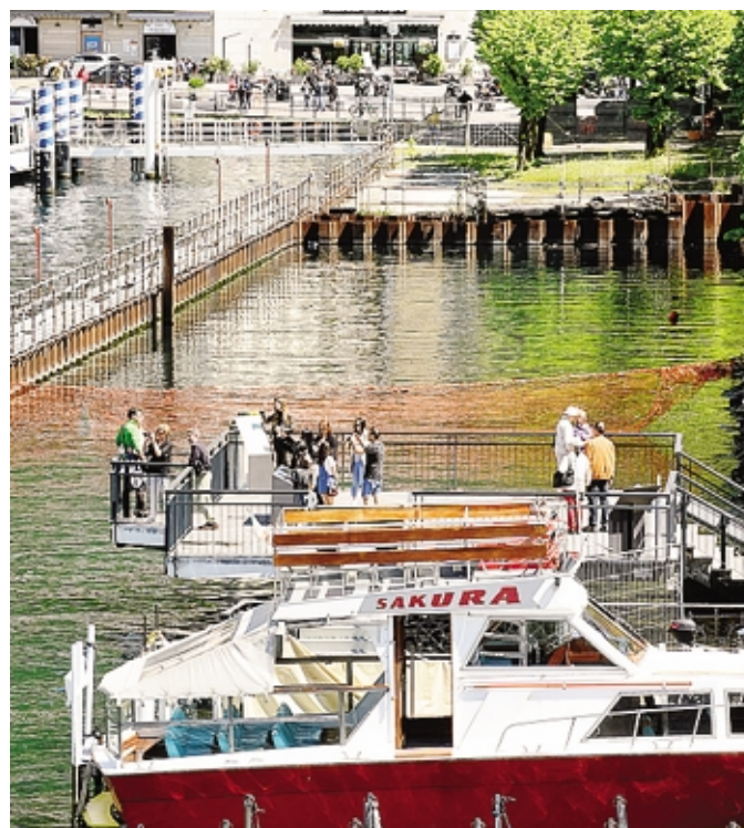
Il cantiere delle paratie dovrebbe ripartire all'inizio dell'anno
