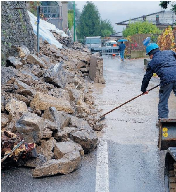
La rimozione dei detriti e la messa in sicurezza dopo la frana del muro di Rovenna (foto Nassa)
