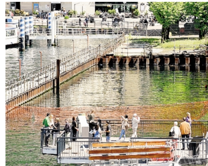
Il cantiere del secondo lotto delle paratie
