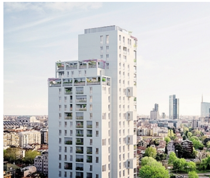
Ecco come sarà la torre
