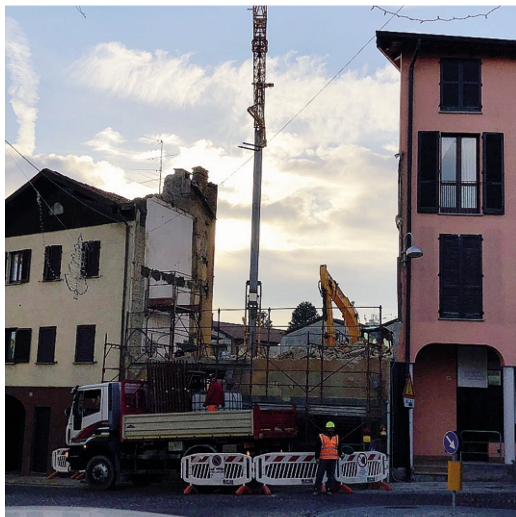
La palazzina sventrata in via San Gerardo, l'ultimo intervento edilizio
