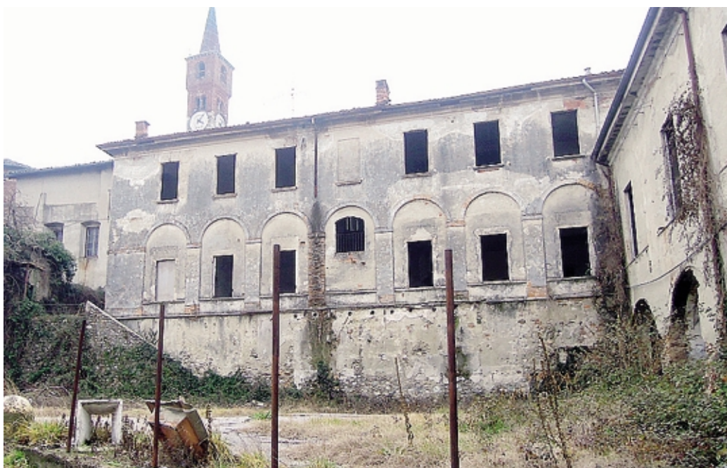
Palazzo Pietrasanta visto dal retro: il degrado dell'area è evidente
