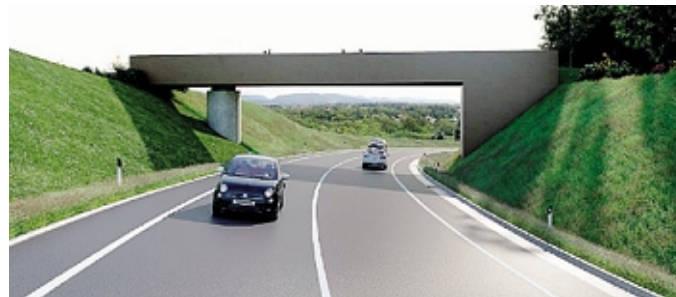
Un tratto della nuova strada
