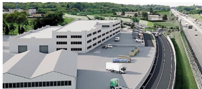
Parte del tracciato correrà a fianco dell'autostrada A9
