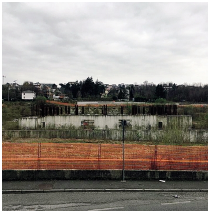
Il cantiere è naufragato e l'area è ora protetta da una recinzione
