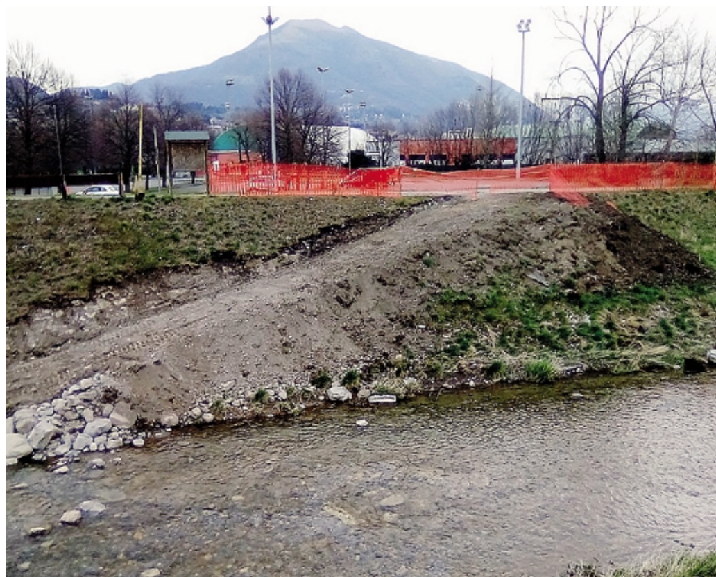
Il cantiere fermo della manutenzione straordinaria del torrente Lambrone
