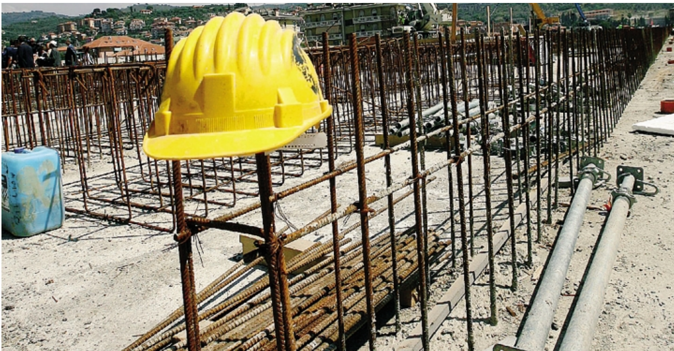
Dopo il lungo stop dei cantieri, in arrivo una misura che incentiva l'edilizia FOTO ANSA
