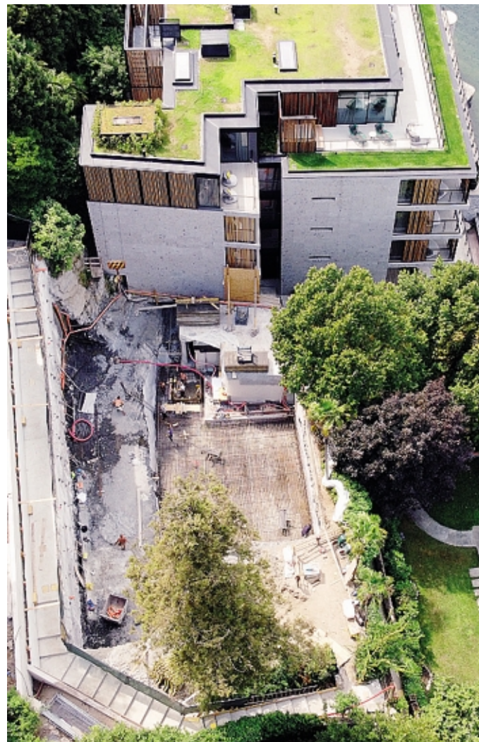
Il cantiere è stato aperto la scorsa primavera
