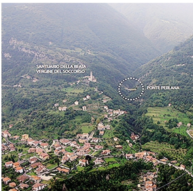
Il Santuario e il ponte Perlana, uno dei punti più delicati del cantiere
