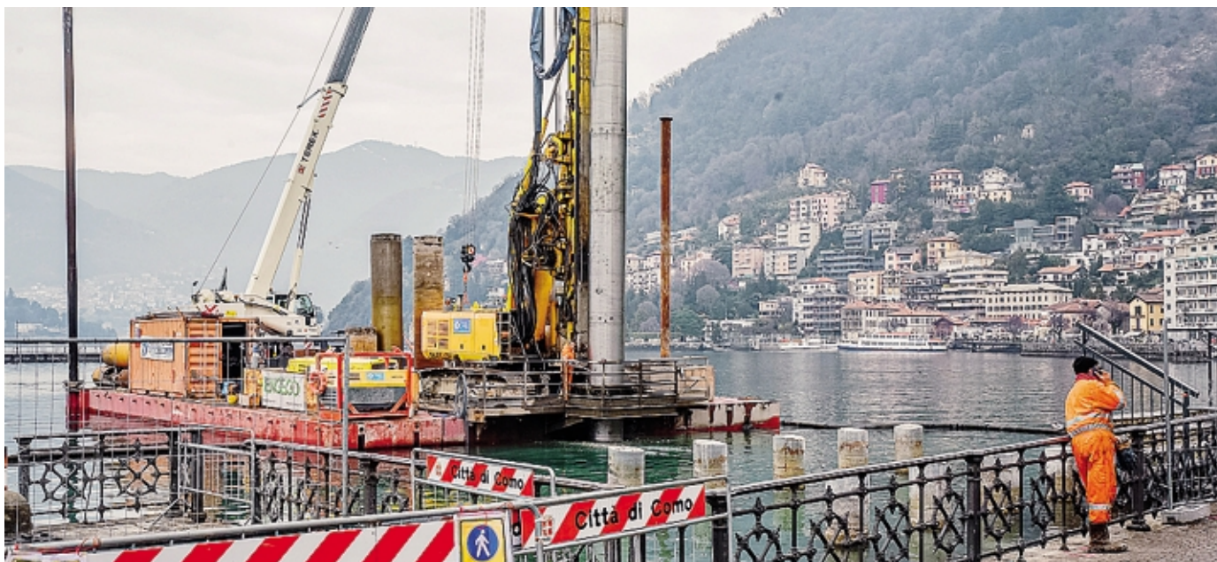
La grossa chiatta con il sistema per l'iniezione dei grossi pali di fondazione della vasca A BUTTI
