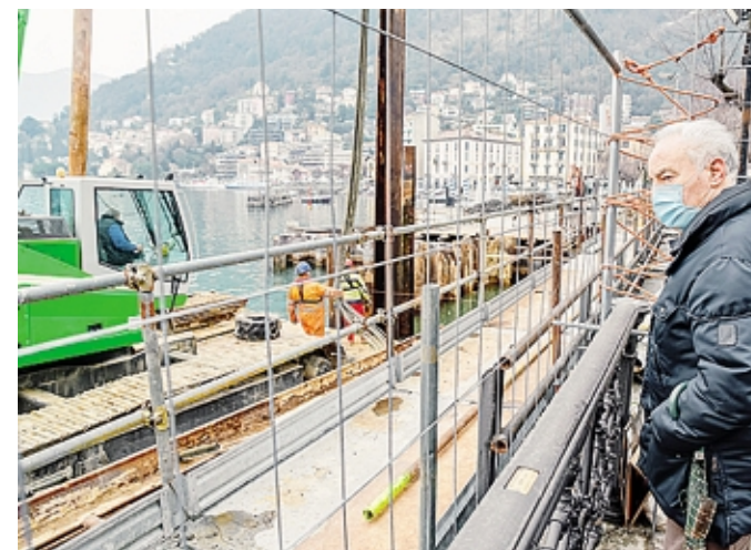
Il cantiere delle paratie è tornato ad attirare i curiosi dietro le grate
