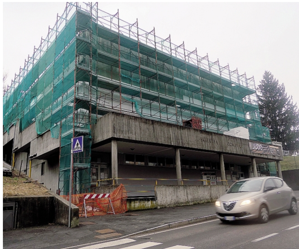
La palestra comunale in cui sono in corso i lavori contestati dal sindaco Capuano BARTESAGHI
