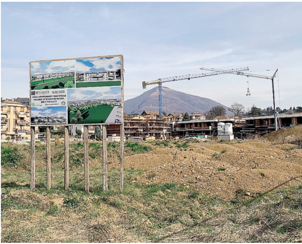
Il cantiere di Incasate dove sono previste palazzine e villette BARTESAGHI
