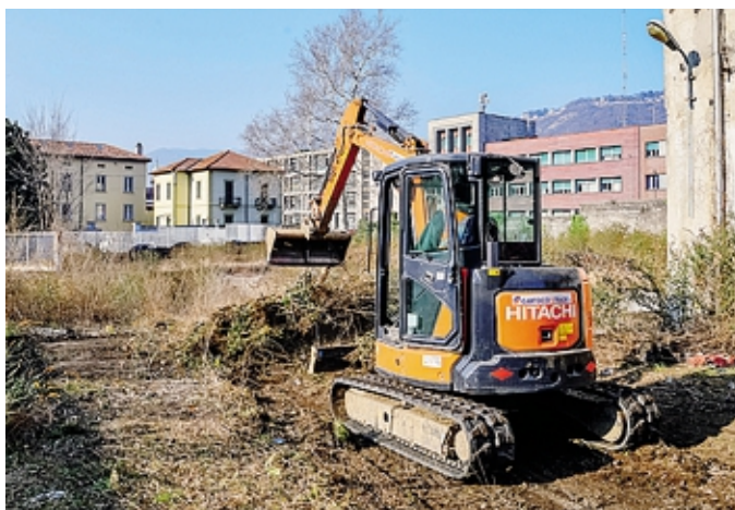
I lavori ieri pomeriggio nell'area che ospiterà il parcheggio BUTTI
