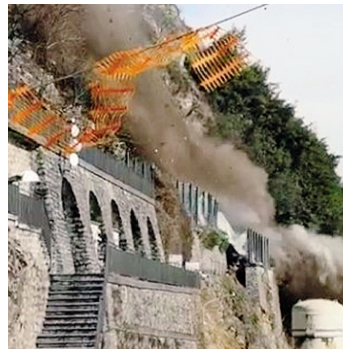
Una delle esplosioni controllate per i lavori della Variante ARCHIVIO
