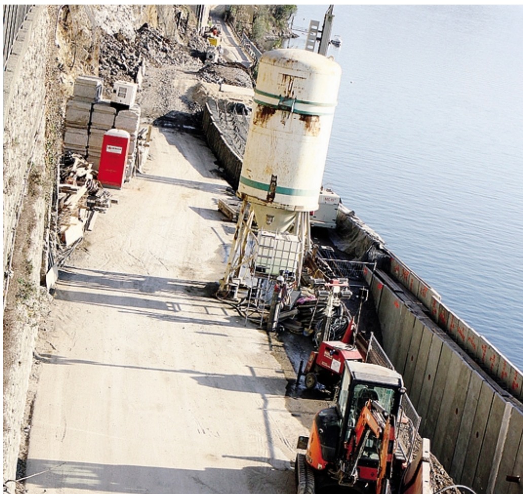
Il cantiere della Variante della Tremezzina: si attende la conferma della riapertura della Regina il 29 marzo
