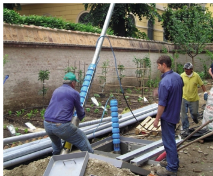
La realizzazione di un impianto geotermico
