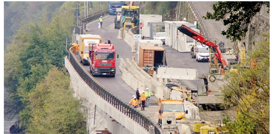
Il cantiere di Anas a Colonno è a pieno regime, apertura confermata per il 5 aprile FOTO SELVA
