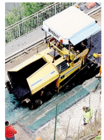
Uno dei mezzi al lavoro
