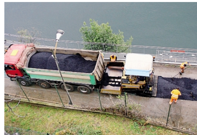
Prosegue anche l'opera di asfaltatura
