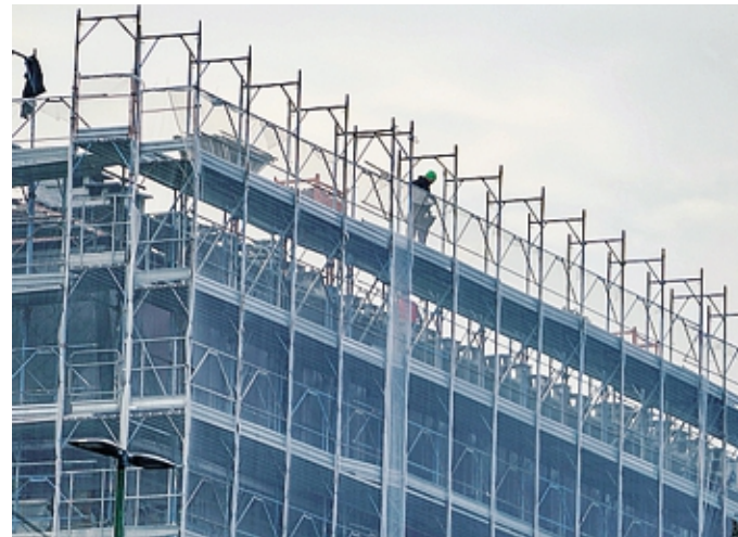
Lavori di riqualificazione energetica in un condominio
