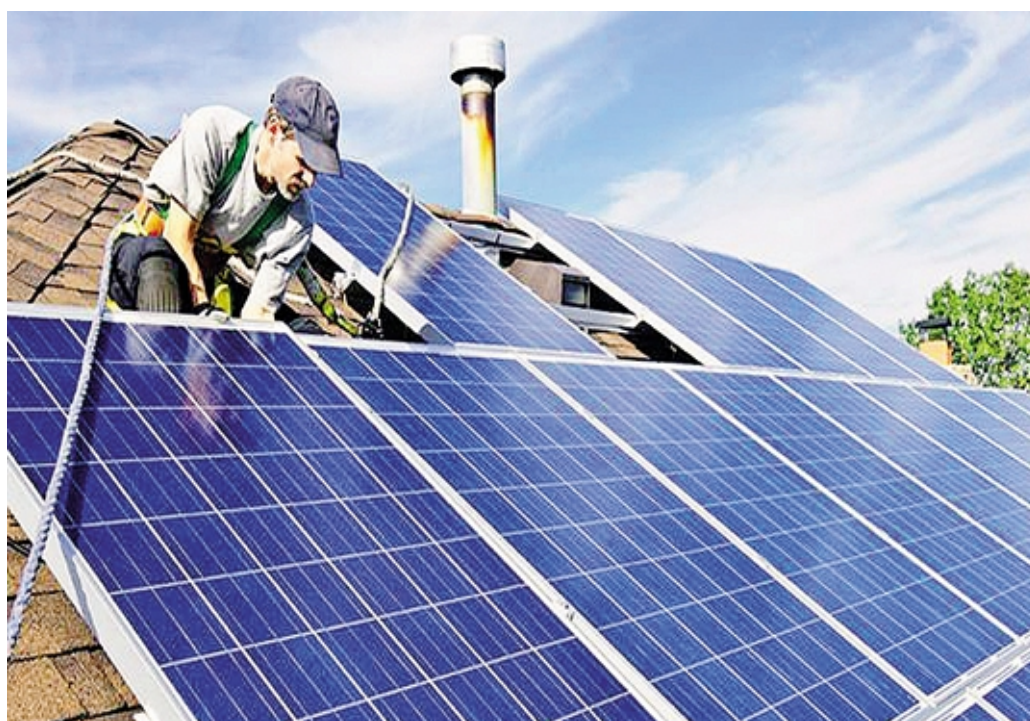
L'installazione di pannelli solari su un tetto
