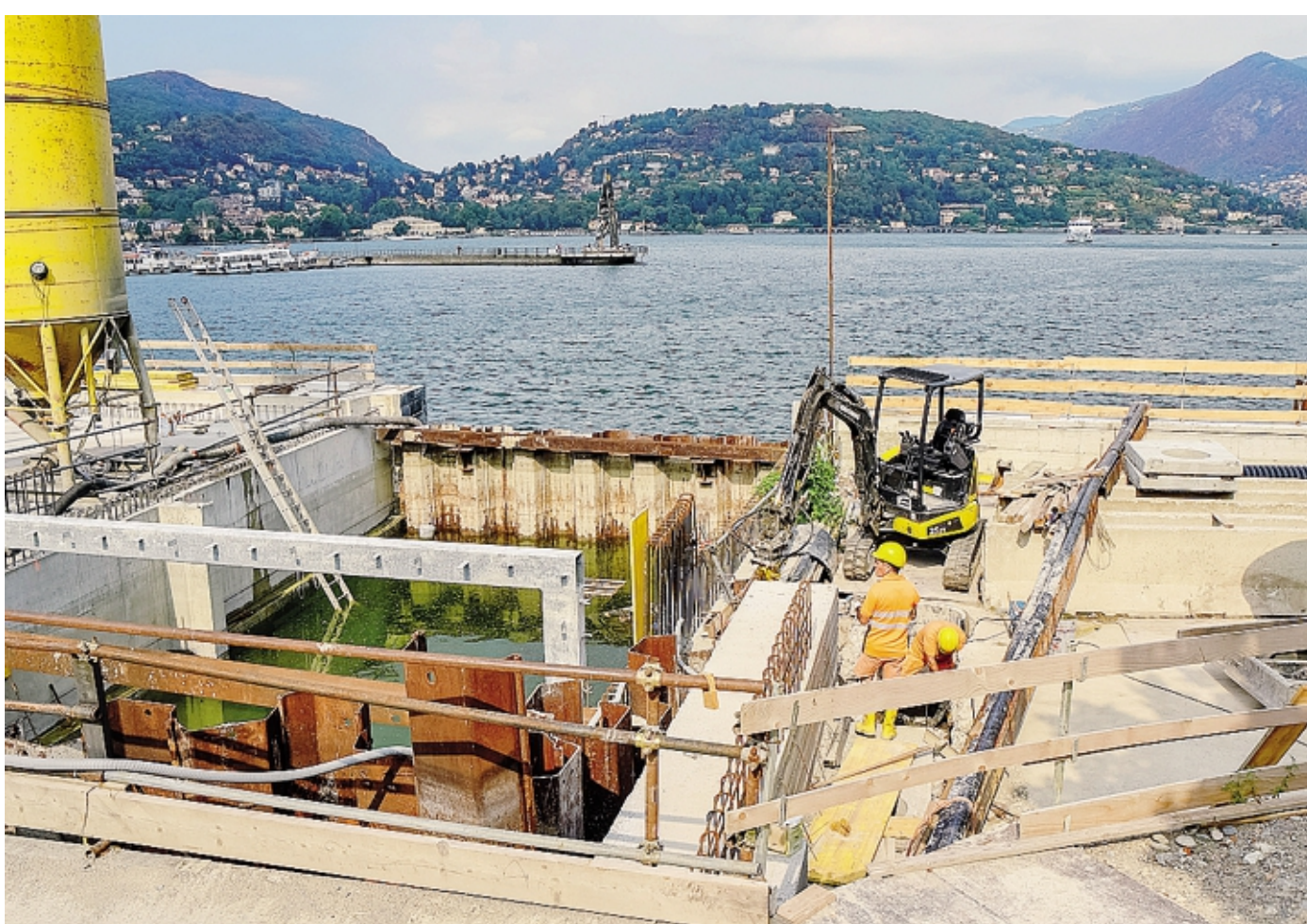
Sul completamento dei lavori delle paratie c'è una garanzia di Regione Lombardia
