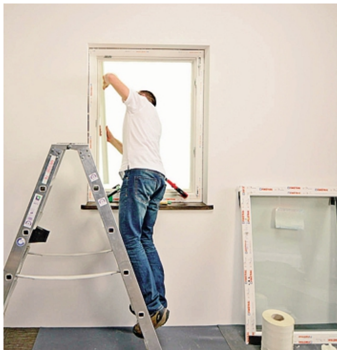
Un intervento di sostituzione degli infissi
