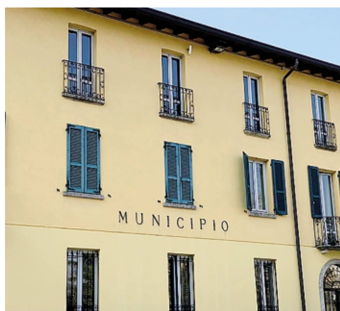
Sono previsti lavori di efficientamento energetico in municipio
