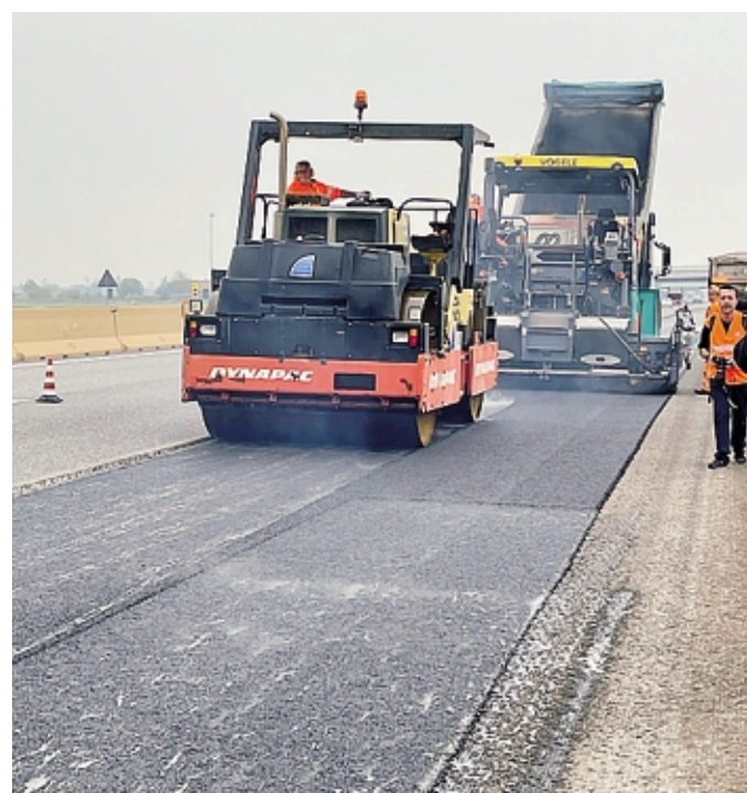
I lavori di asfaltatura sulla Milano Torino
