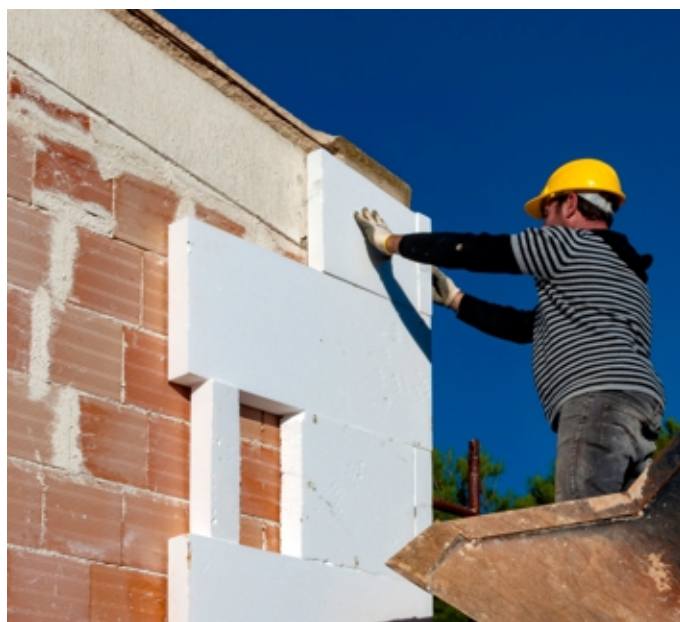
Un intervento di isolamento termico di un edificio
