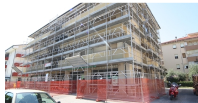
Lavori di riqualificazione di un piccolo condominio
