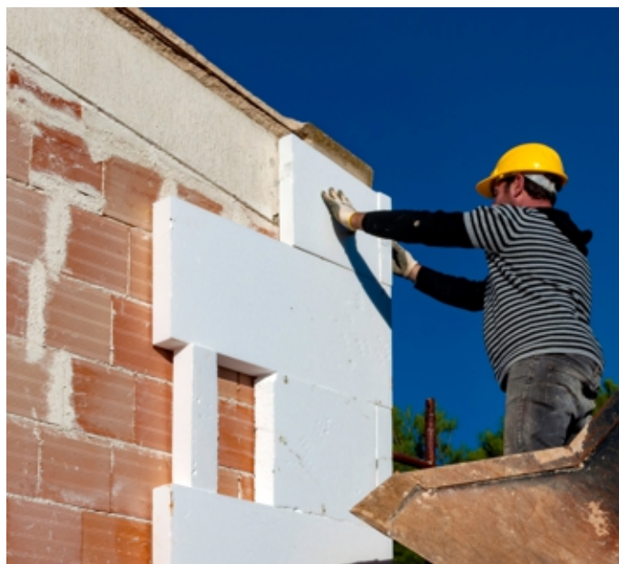
Un intervento di isolamento di un edificio
