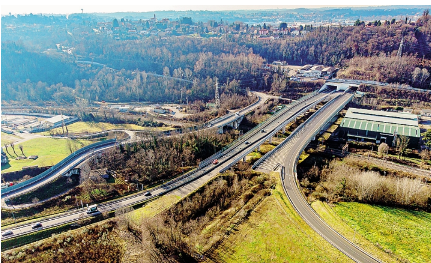
Una veduta aerea del primo lotto della tangenziale di Como, con il tracciato interrotto
