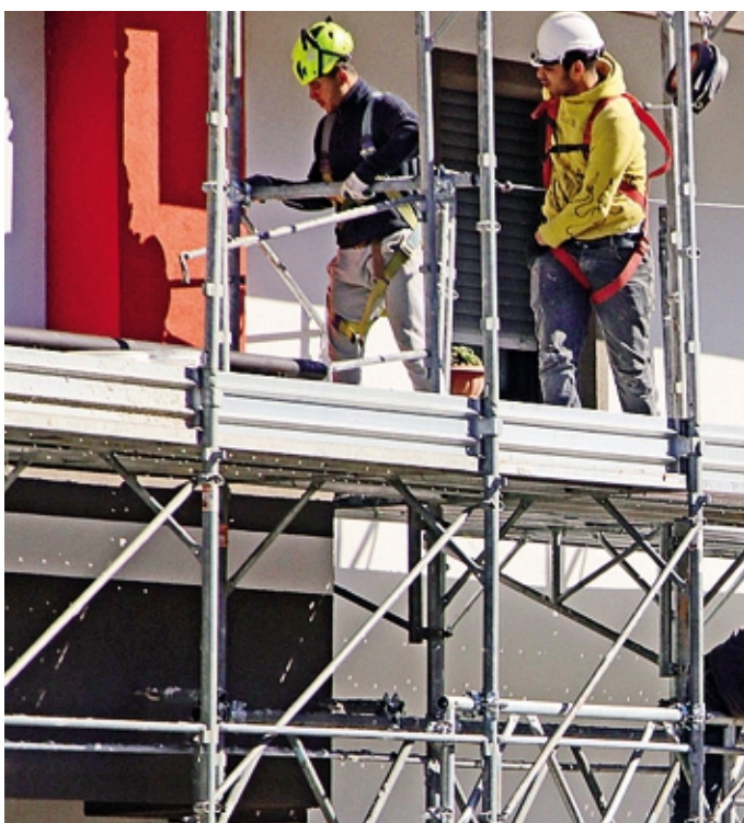
Lavori di riqualificazione energetica di un condominio
