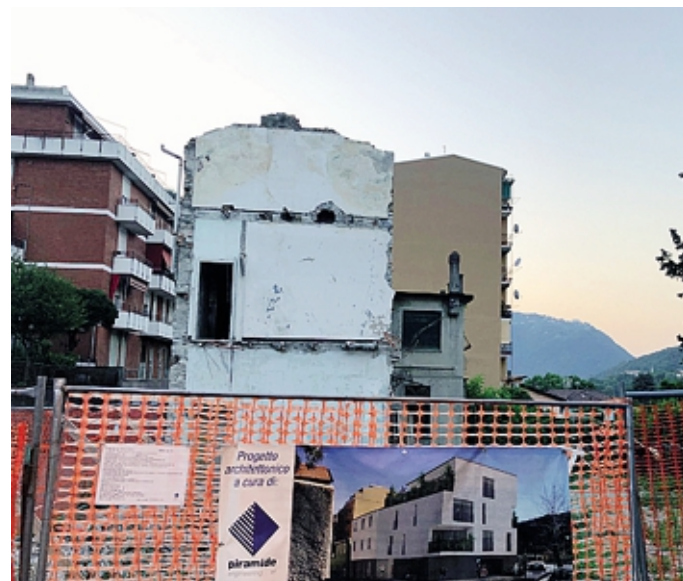
L'area di cantiere a Como in zona università
