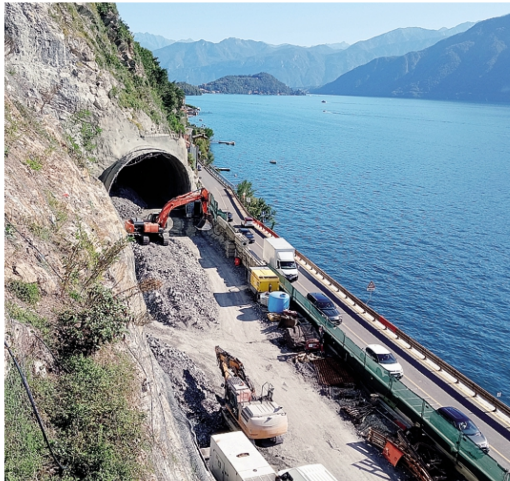
I lavori attualmente in corso alla galleria principale Comacina di Colonno
