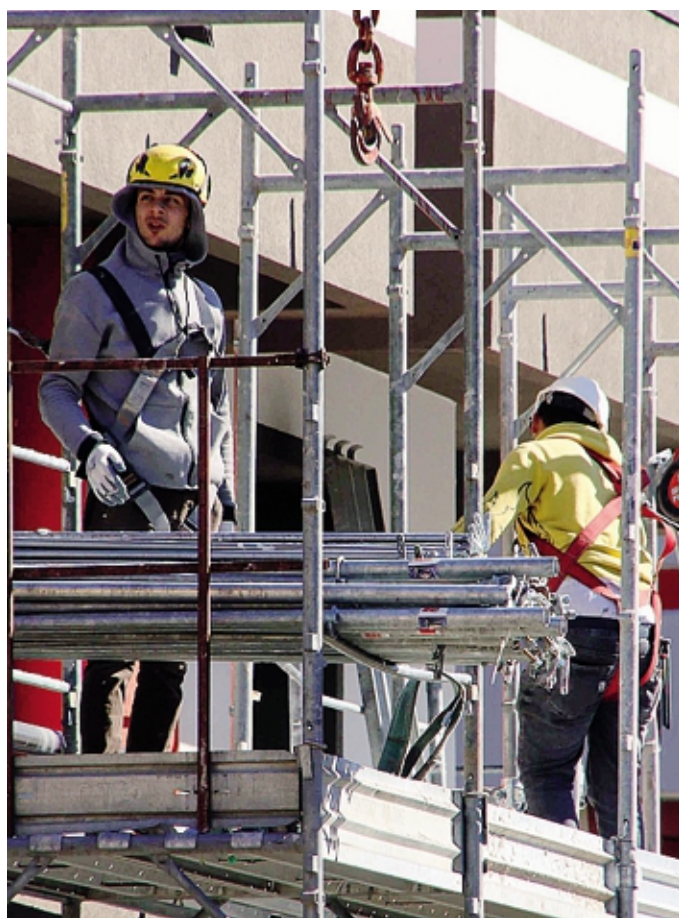
Lavori di riqualificazione energetica di un edificio
