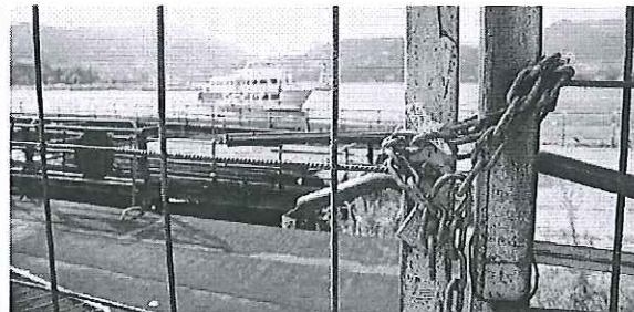
Il cantiere sul lungolago comasco in un'immagine che ne denuncia in modo eloquente l'immobilità
