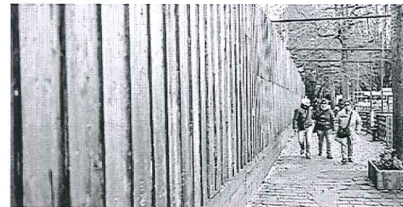
La palizzata che delimita l'area di cantiere
